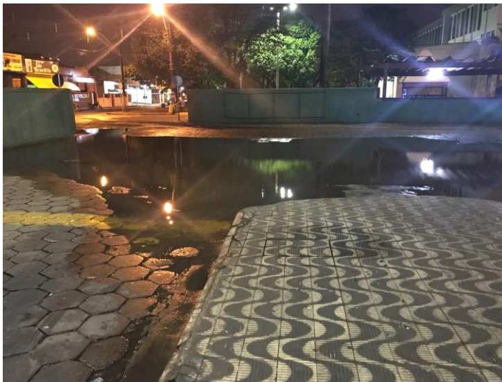
Imagem 14: Alagamento. Fonte: Elaborada pelo autor.
